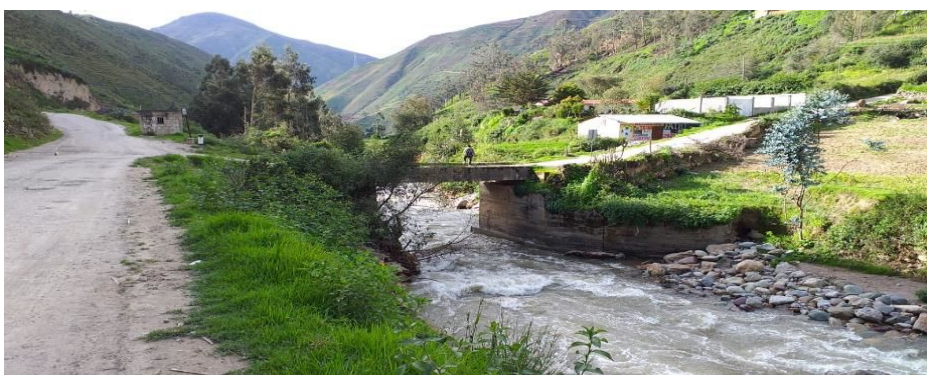
FIGURA N°03: PUENTE VEHICULAR DE ACCESO SOCAVADO POR EL RIO, PUENTE CON MAS DE 40 AÑOS DESDE SU CONSTRUCCIÓN.
